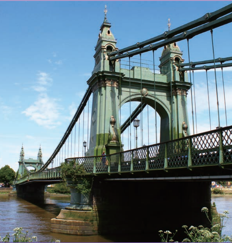
ハーマスミス橋 ロンドン西部のハーマスミス橋は2代目。初代の橋は1827年開通したテムズ川に架かる最初の吊り橋だったが、交通量の増加で新しい橋が1887年に完成した。地下鉄のハーマスミス駅から徒歩で5分足らず、川沿いにお茶や軽食もできるパブもある。中でもパブ「ラトランド・アームズ」は映画「ボヘミアン・ラプソディ」にも登場した。なお、橋は現在老朽化のため渡ることができない。
